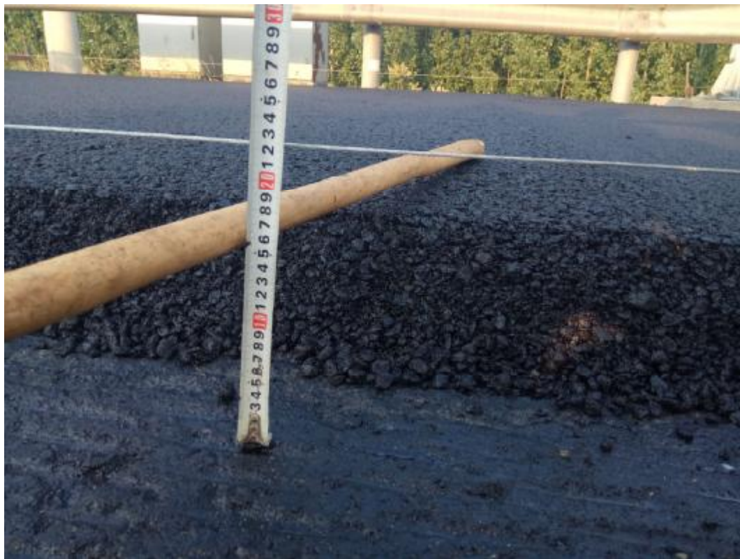
桥头跳车注浆孔现场深度检测
