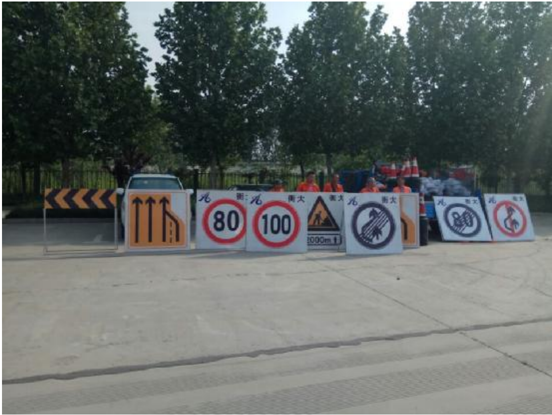
安全标志标牌进场验收
