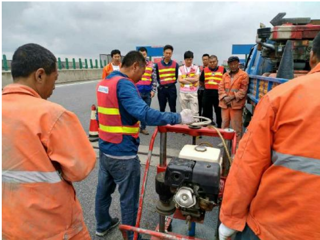
桥头跳车处治沥青路面厚度钻心检测
