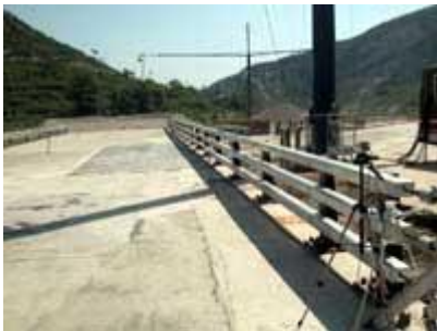
深圳湾公路大桥护栏
