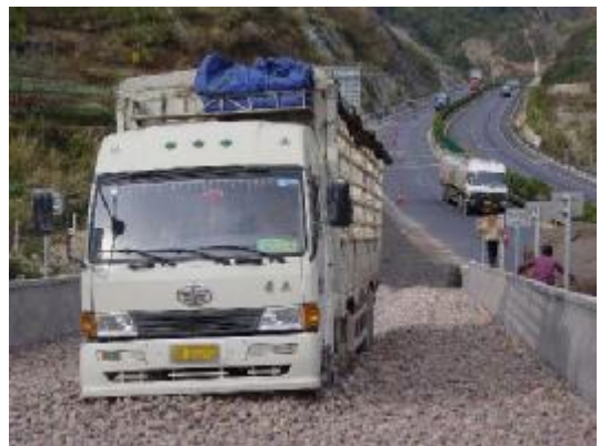
云南省某高速公路上的紧急避险车道
